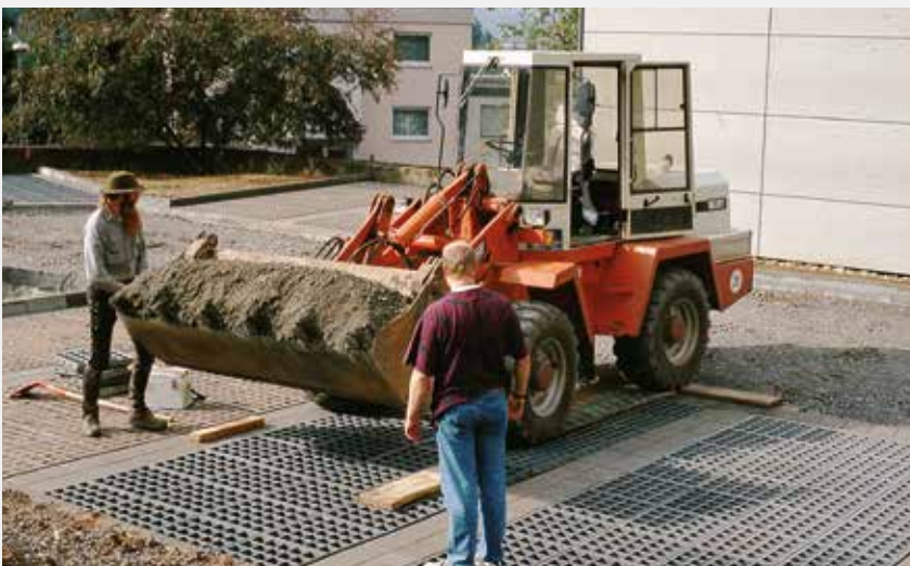
Fugenverfüllung nach dem Verlegen auf 2-3 cm Ausgleichsschicht.
