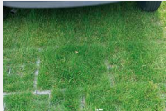
TTE-Rasengitter im Fugenversatz im Sommer 2002.
