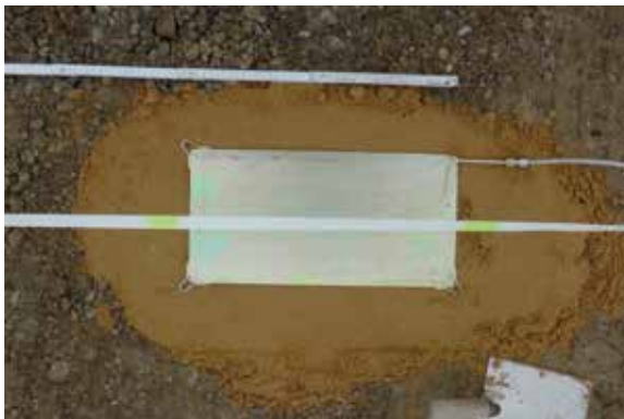
Bild 2: Messdose auf verbessertem Bodenplanum, vor Einbau der Tragschicht.
