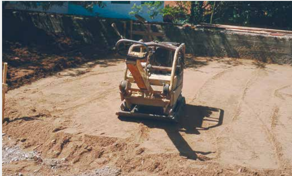
Einbau eines nicht bindigen Untergrundmaterials auf der Versuchsfläche.
