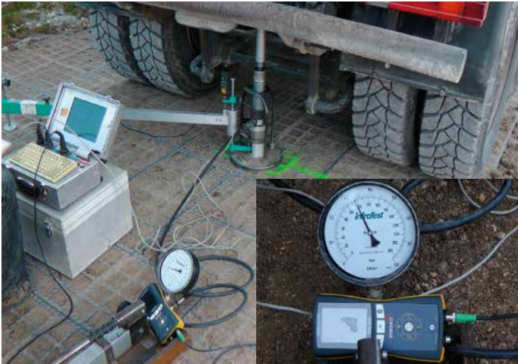
Bild 1: Durchführung Lastplattendruckversuch mit Messung der reduzierten Belastung am Bodenplanum
