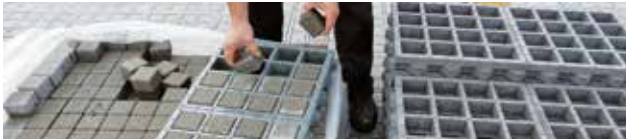
Einsetzen der Pflastersteine in das TTE®-Element
